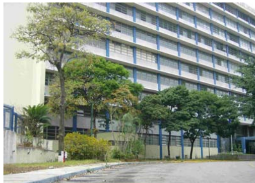
EDIFICIO SHELL, luego LAGOVEN, Los Chaguaramos, Caracas
